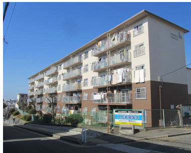
外壁改修 (東垂水団地)
