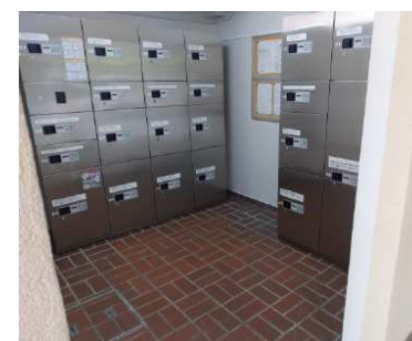
宅配ボックス新設 (西宮田近野(3)団地)
