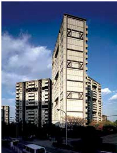
芦屋浜若葉・高浜高層住宅（1976）
